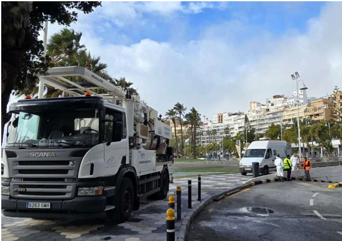
Limpieza de imbornales (MANCOMUNIDAD)
