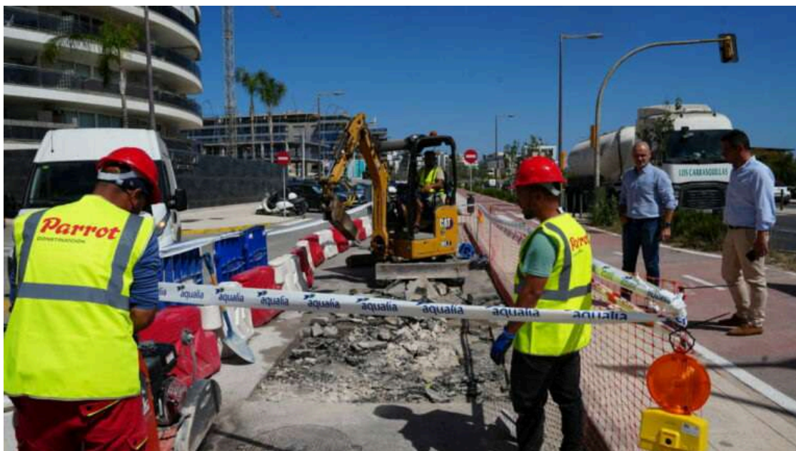
Ibiza sella su alcantarillado para frenar la entrada de agua de mar
